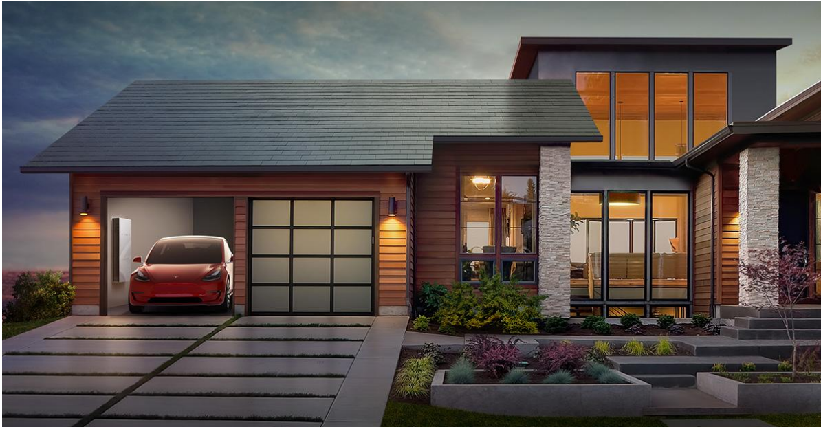
Slika 4: Primer realizacije integralne rešitve sončne energije (Tesla, vir: www.tesla.com).
